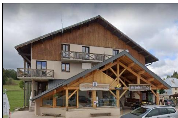
Figure 1 : bâtiment d'origine (façade Est)
