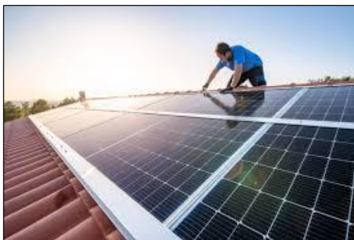
Figure 8 : pose de panneaux PV en surimposition
