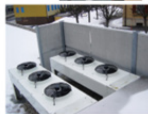
Mur anti-bruit protègent les habitations riveraines du bruit des équipements de ventilation (Acouever Iso)
