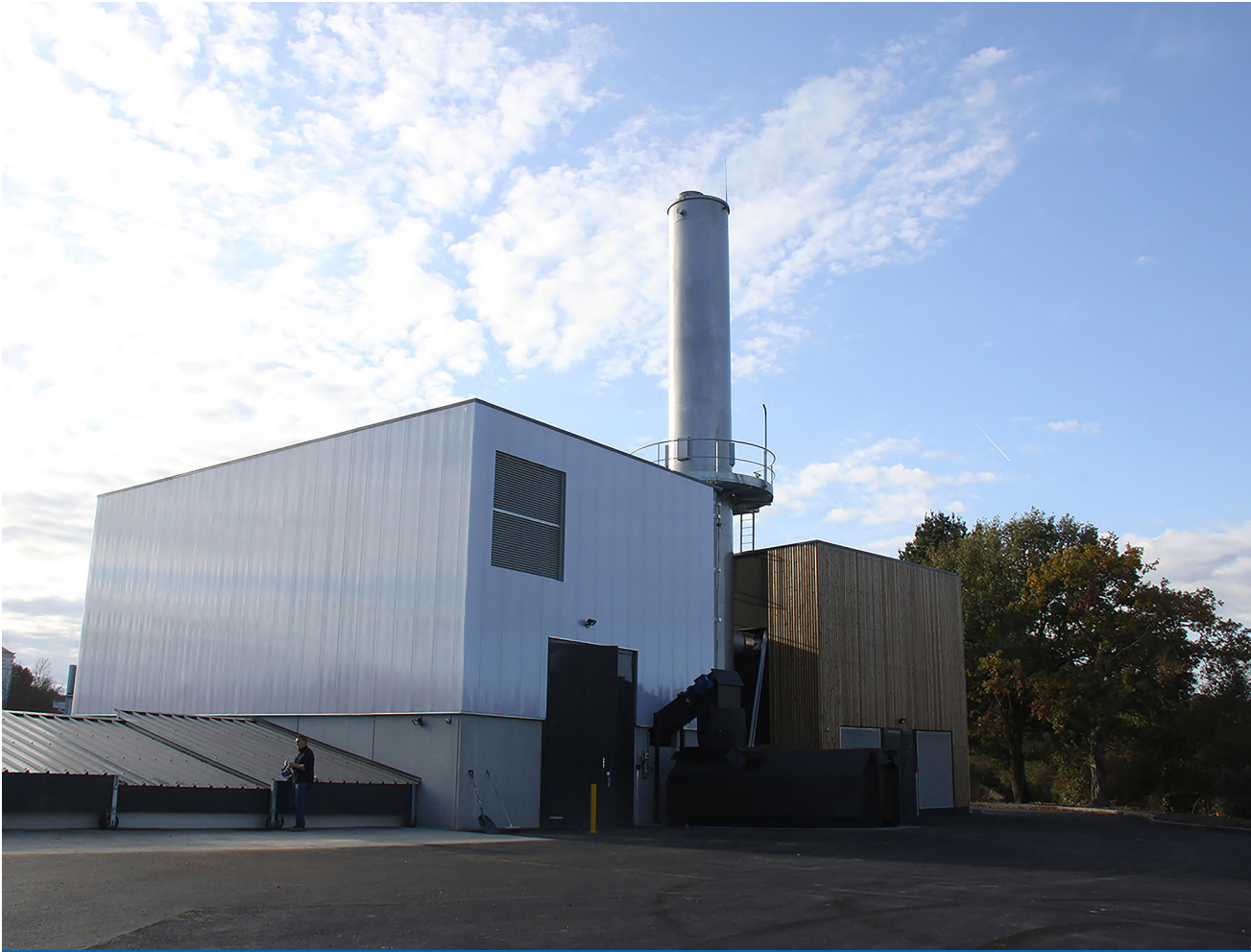
Chaufferie à bois
