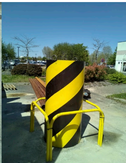
À gauche : tête de forage inox verrouillée avant mise en place des équipements Au centre : protection de la tête de forage en attente de l'avancement des travaux sur le site À droite : coupe géologique établie via l'identification des cuttings recueillis lors de la foration et coupe technique du forage
