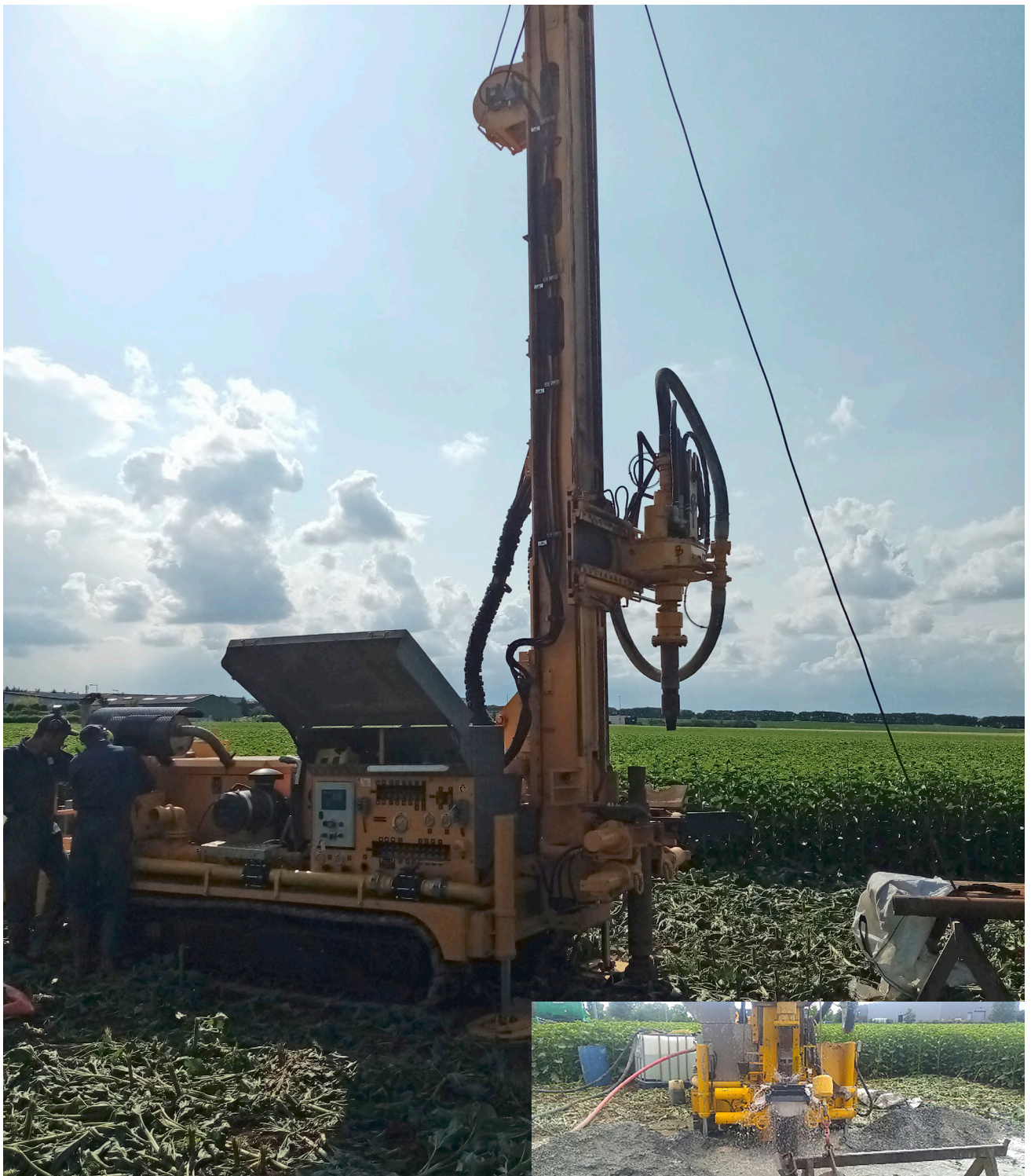
Forage sur le Dogger
