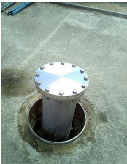
À gauche : tête de forage inox verrouillée avant mise en place des équipements Au centre : protection de la tête de forage en attente de l'avancement des travaux sur le site À droite : coupe géologique établie via l'identification des cuttings recueillis lors de la foration et coupe technique du forage
