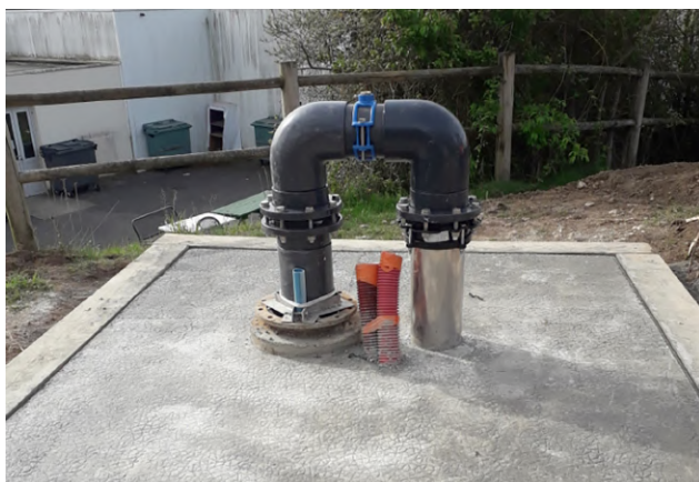
Forage d'essai sur nappe au Futuroscope (86)
