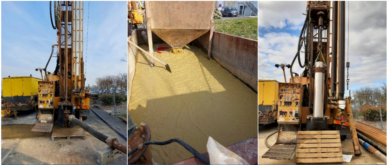
Photos prises lors des travaux de reconnaissance sur le forage d'exhaure du PRC2 À gauche : machine de forage avec mise en place d'un circuit fermé pour la récupération des déblais de foration et des eaux - demande du CHU pour éviter tout risque de ruissellement d'eau chargée en particules sur les parkings Au centre : bac de récupération des déblais de foration (=cuttings) et des eaux chargées en phase de foration À droite : mise en place des crépines inox dans le forage
