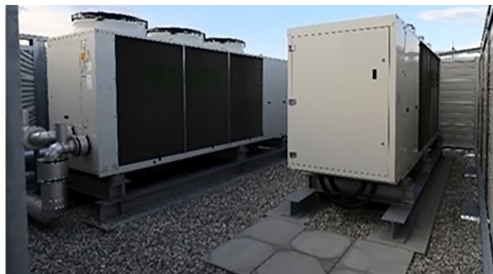
Fig.1 : système PAC en monovalence : bâtiment (gauche) ; PAC air/eau en toiture, avec panneaux insonorisants (droite)
