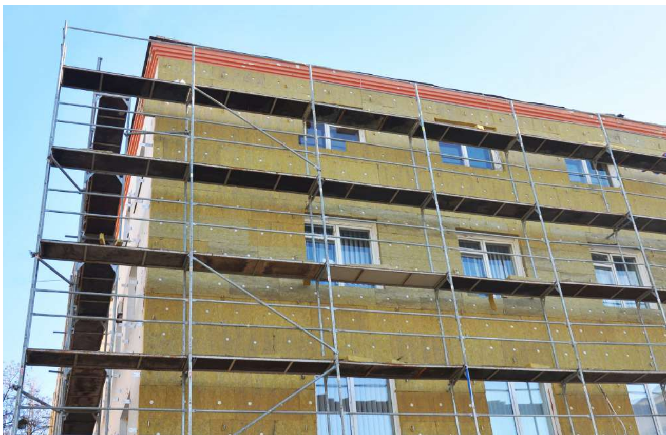
Travaux d'isolation thermique par l'extérieur en logement social
