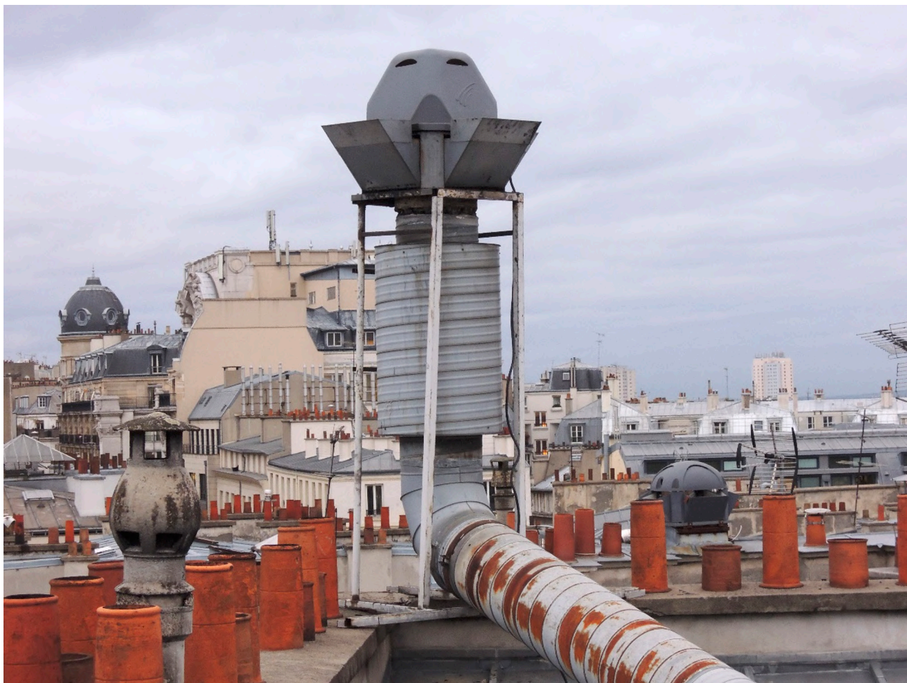
Cas récurrent de bruits de voisinage 1 : extracteur de buées d'un restaurant
