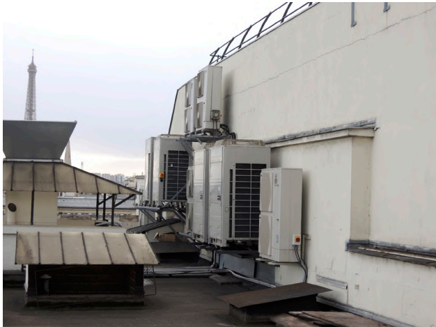
Cas récurrent de bruits de voisinage 2 : climatiseurs V.R.V. et unités extérieures
