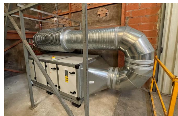
Air de compensation des laboratoires
