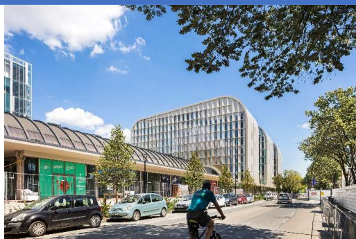
HALLE BOCA - BORDEAUX (Eiffage Construction Nord-Aquitaine) 208 Quai de Paludate
