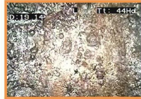
→ Ouvrage en bon état structurel avec épaisseur de dépôt estimée à 6 mètres
