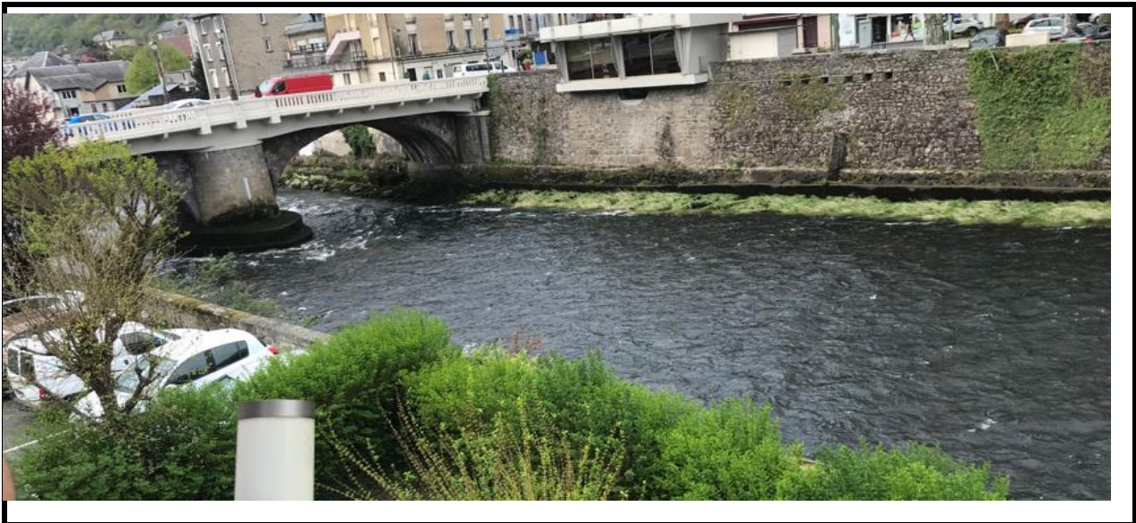
Vague avec lachée d'eau barrage constatées
