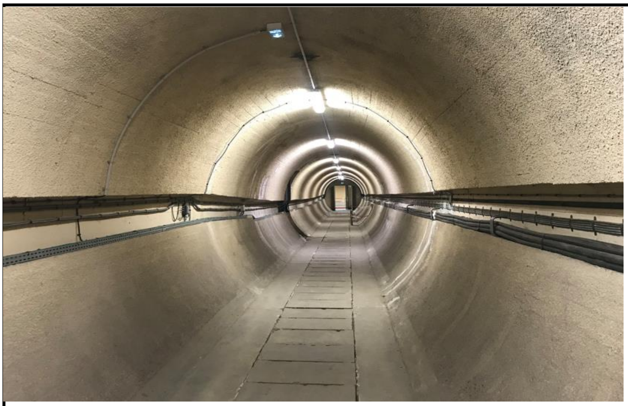
Gallerie en pied du Barrage
