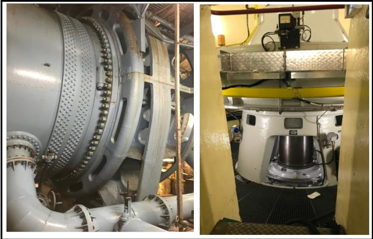
Une des 2 canalisations de 5 mètres de diamètre avec l'axe de la turbine
