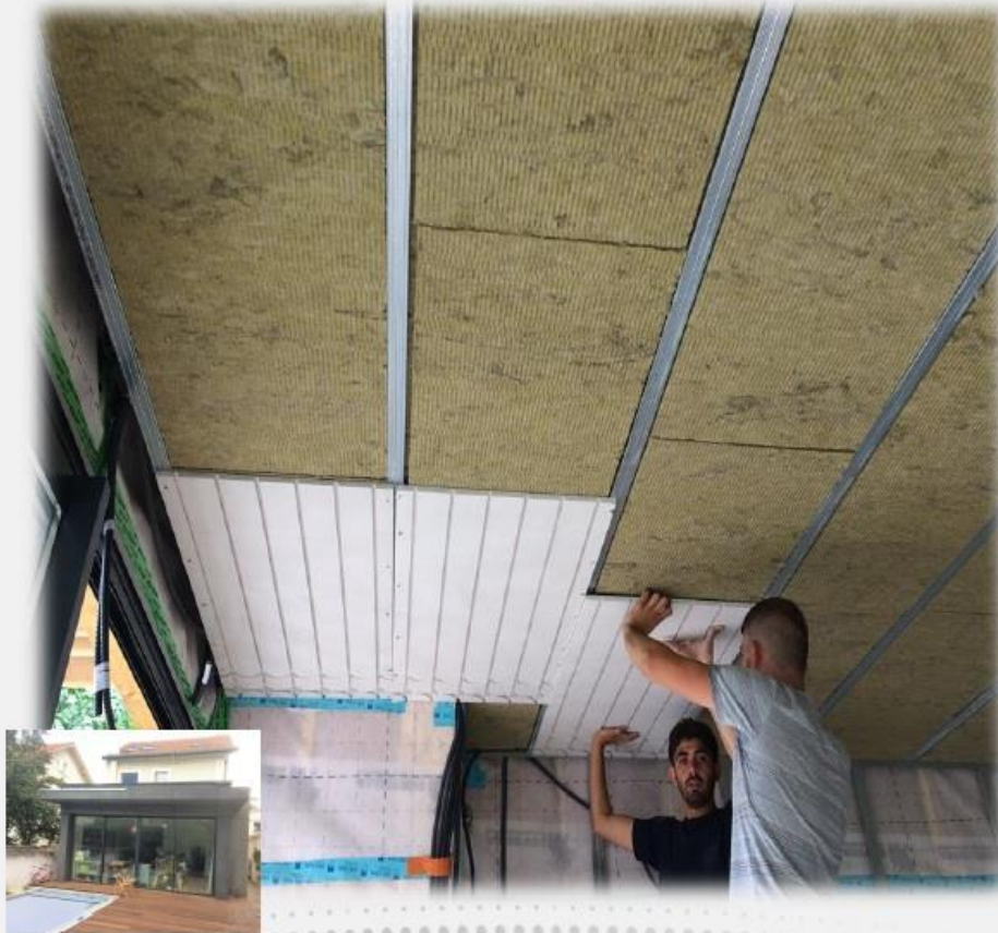
Plaques RayZeau® vissées sous l'ossature
