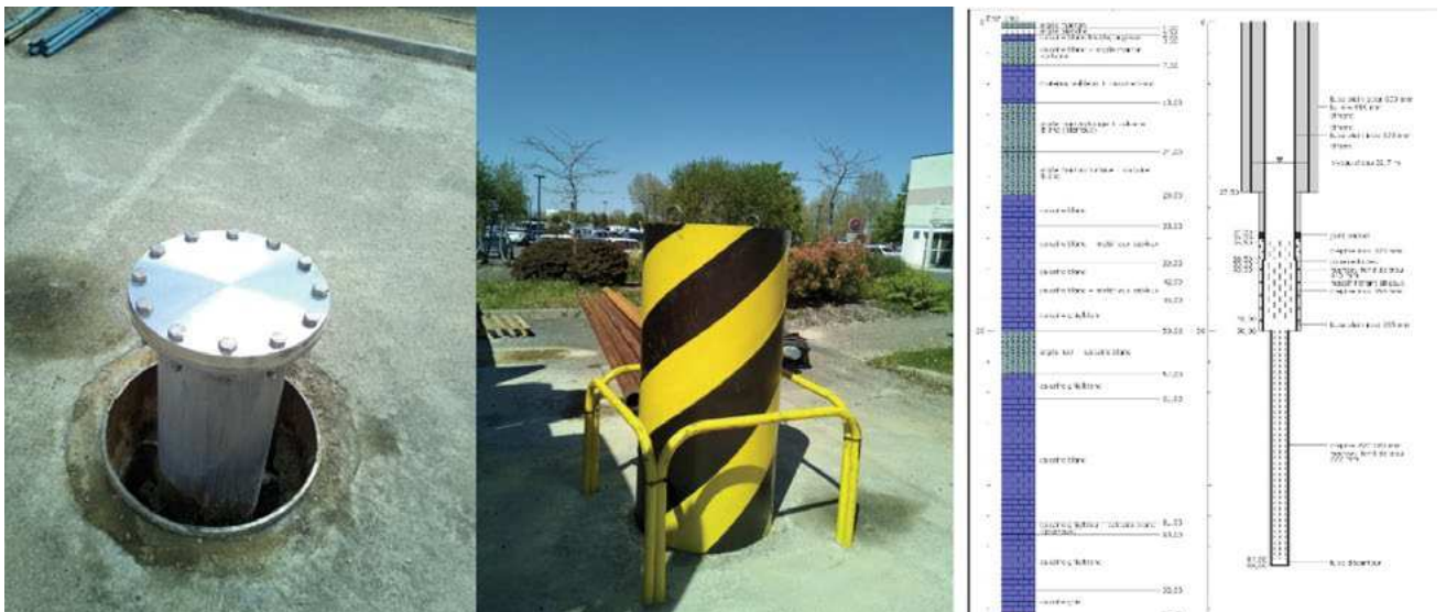
À gauche : tête de forage inox verrouillée avant mise en place des équipements Au centre : protection de la tête de forage en attente de l'avancement des travaux sur le site À droite : coupe géologique établie via l'identification des cuttings recueillis lors de la foration et coupe technique du forage
