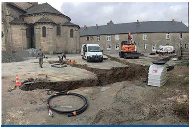
Raccordement du champ de sondes - Bénévot l'Abbaye (23)
