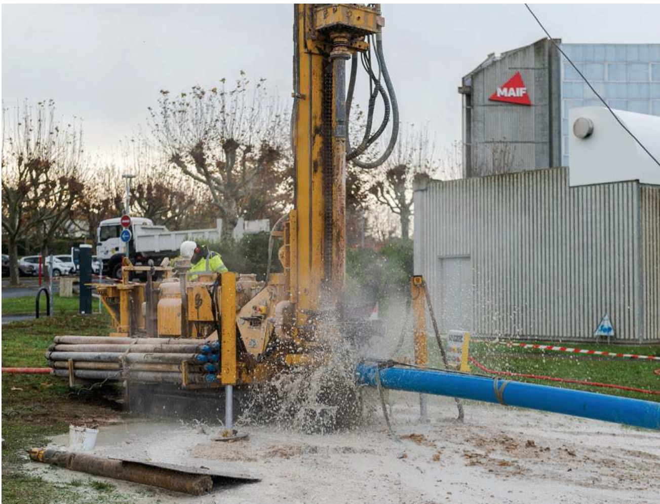
Forage d'un des puits de la géothermie
