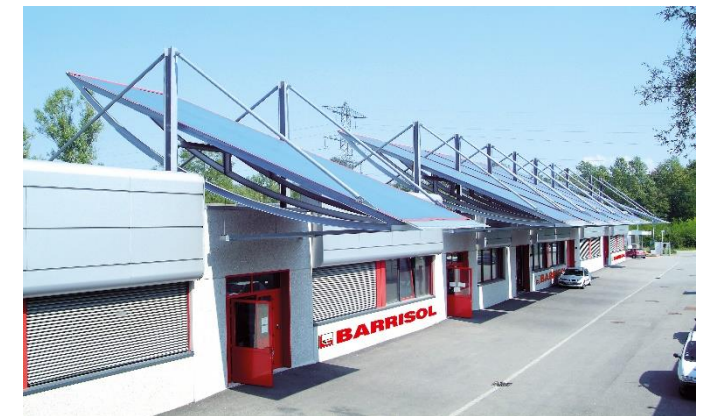
Barrisol® - site de production de Kembs - France
