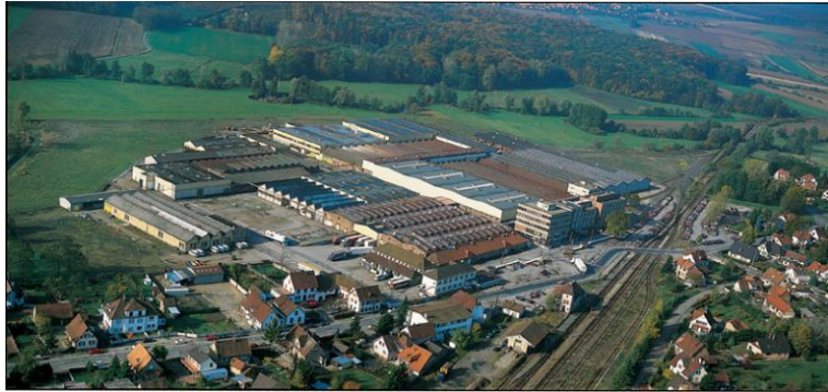
Usine de Mertzwiller (67)
