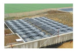
soit dans des « piscines » comme à l'hôpital de Hautepierre à Strasbourg (60 MW de stockage). L'ensemble est piloté par un système de contrôle commande avec priorisation des producteurs de froid en fonction du tarif électrique, des conditions extérieures et de la charge prévisionnelle.
