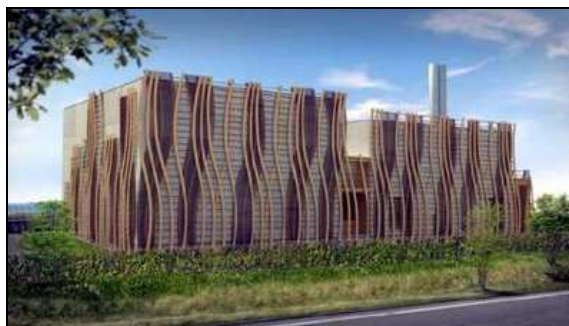
La chaufferie bois de Croix Rouge – Murigny 1 vue depuis la route d'Epernay
