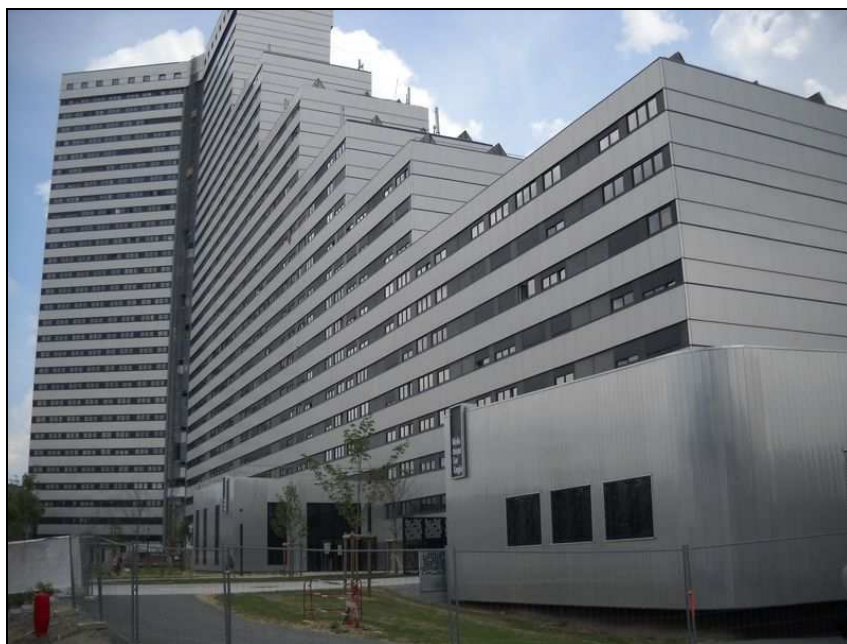
IGH de Sillon de Bretagne après réhabilitation énergétique
