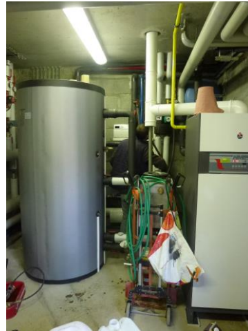
Pendant les travaux
