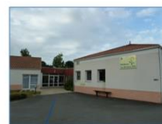
Entrée du bâtiment
