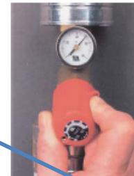
Pendant les chocs thermiques, il est possible de régler la consigne à 80 °C en prenant les précautions d'usage afin d'éviter les risques de brûlures.
