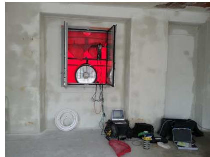
1 er test d'étanchéité à l'air
