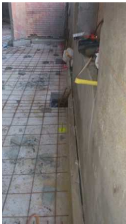
140mm d'isolant sous dallage et plancher intermédiaire en entrevous PSE avec traitements des abouts de dalle en périphérie.
