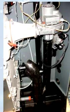
Ratio air gaz optimisé Ventilateur à vitesse variable
