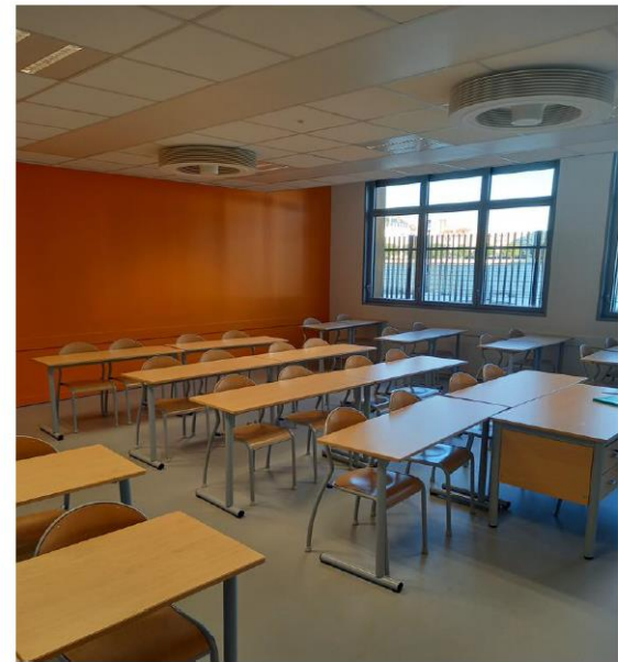
Ex : Classe du collège Pré Gaudry à Lyon (2 brasseurs d'air Exhale en couplage avec des solutions adiabatiques).
