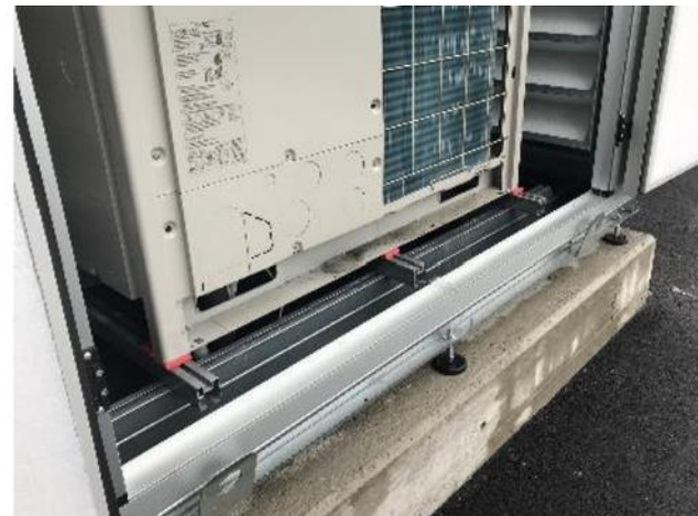
Rails de montage réglables avec plaques d'amortissement Sylomer (standard)
