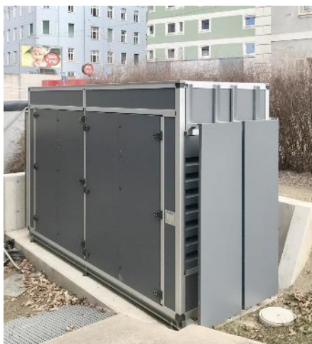
Plaques déflectrices supplémentaires pour augmenter l'atténuation du son côté aspiration
