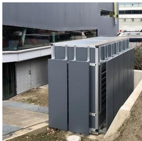
Plaques déflectrices supplémentaires pour augmenter l'atténuation du son côté aspiration
