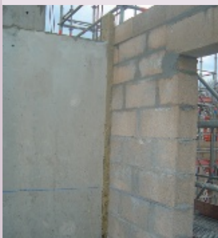
Image 3 Jonction verticale avec un refend béton
