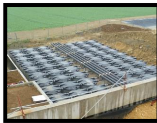
Le stockage de glace dans des bacs à l'hôpital Mercy de METZ
