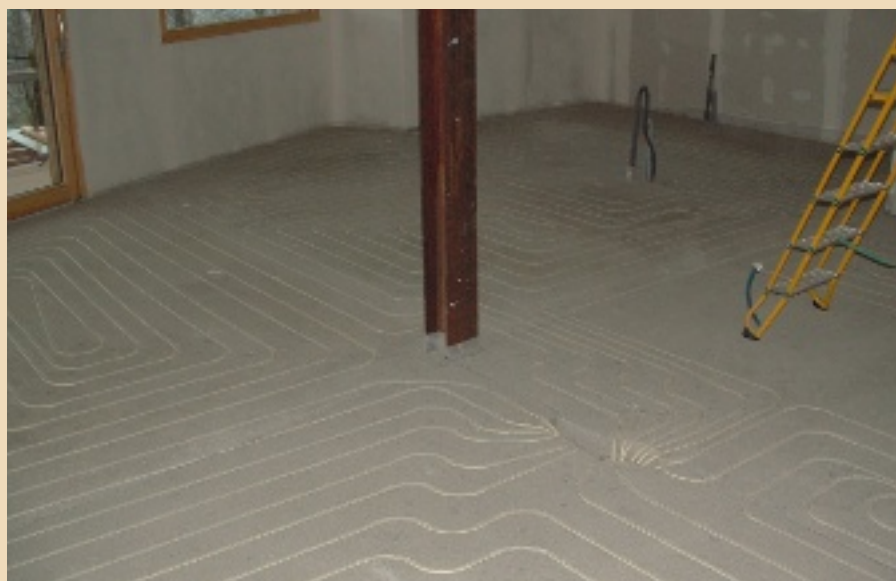
Figure 1 Les tubes de diamètre 10/12 des planchers chauffants Péritherm sont placés juste sous le revêtement de sol dans des rainures réalisées dans la chape, isolée en sous-face.
