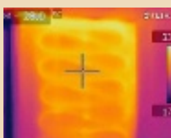
Figure 3 Photo du mur chauffant prise avec une caméra infrarouge début février 2015
